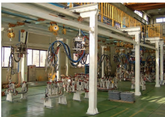
수동 Portable 라인 1 / Manual portable welding line 1
